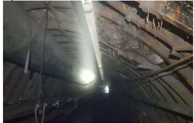
Рис. 7 – Локальна деформація конвеєрного штреку на етапі проведення.
