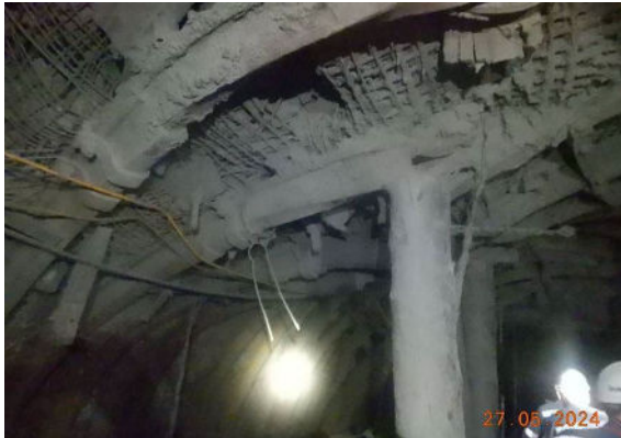
Рис. 9 – Локальна деформація конвеєрного штреку на етапі підтримання за очисним вибоєм.
