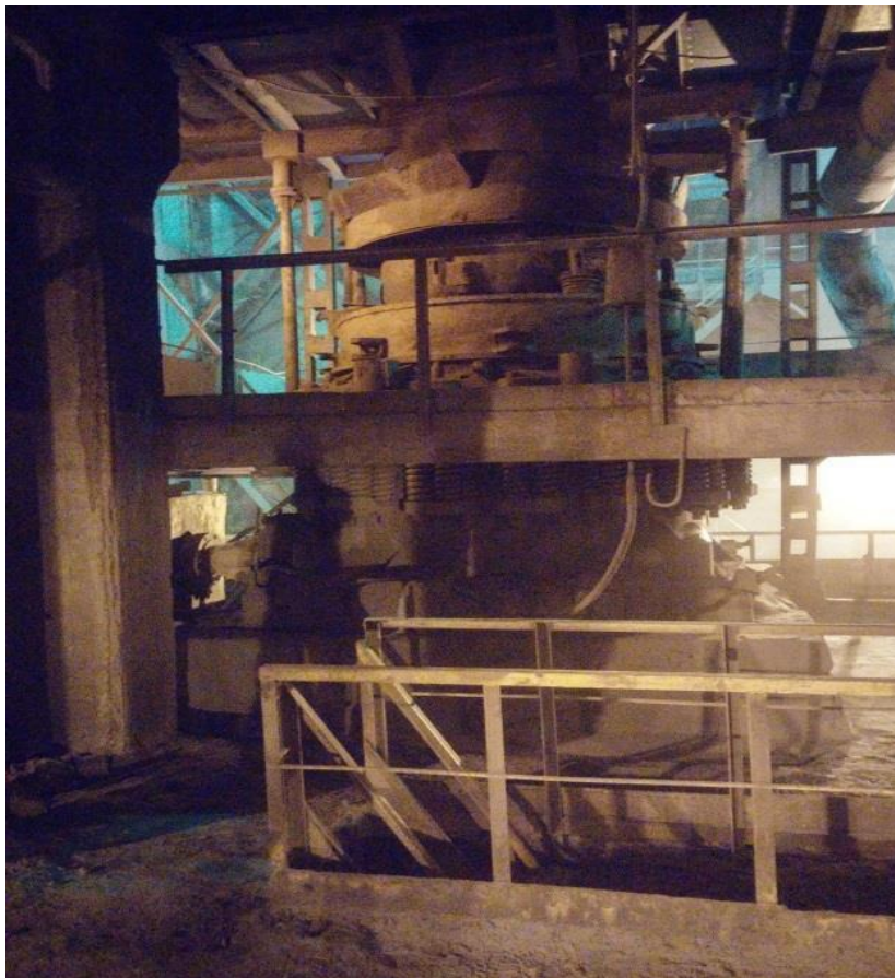
Рис.1.2. Загальний вигляд дробарки
