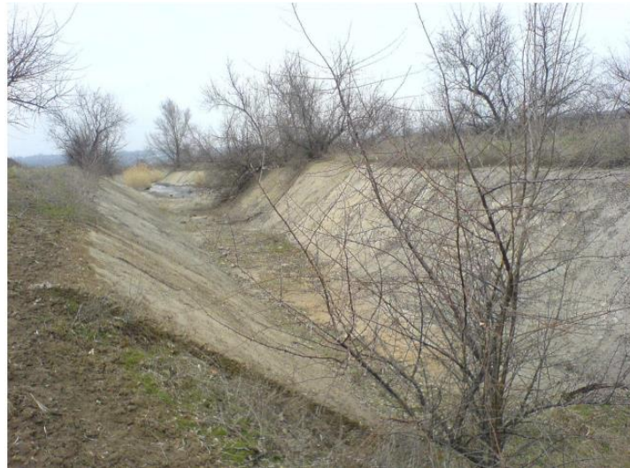
Рисунок 4.4 – Нагірна канава хвостосховища (м. Жовті Води; за даними НВП «Центр екологічного аудиту та чистих технологій»)
