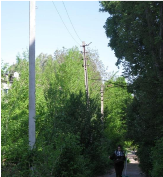
Рисунок 2 – Нахилений стовп, як приклад п'яного лісу
