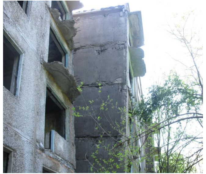
Рисунок 3 – Деформація п'ятиповерхових будинків
