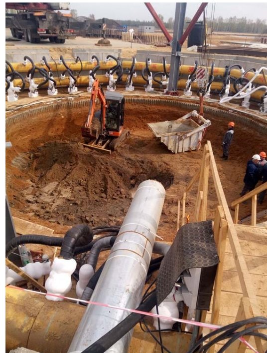
Рис. 4. Облаштування технологічного відходу із застосуванням заморожування
