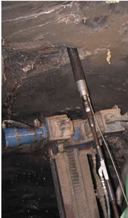
Рис. 7. Роботи з водопридушення
