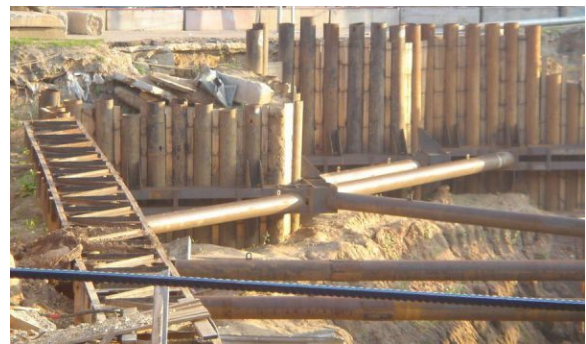
Рис. 8. Випереджуюче кріплення
