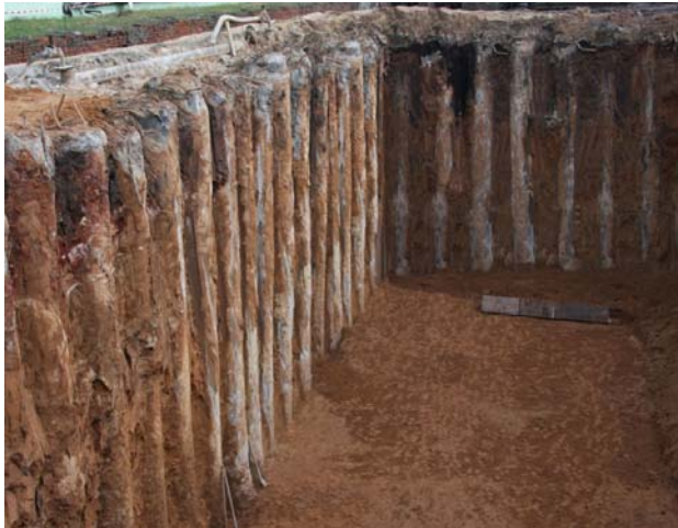
Рис. 9. Буросічні палі по периметру котловану
