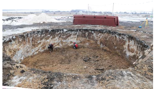
Рис. 6. Деталі опускного «ножа» на проммайданчику блоку №12 ШУ «Покровське», лютий 2021 р.
