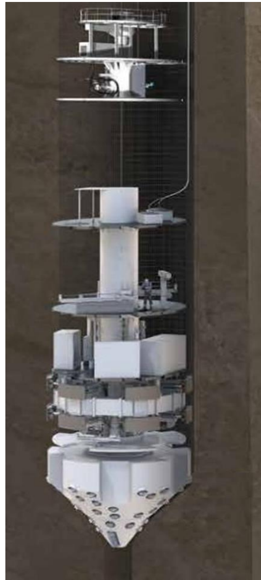
Рис. 20. Проходка ствола комплексом SBE з передовою свердловиною
