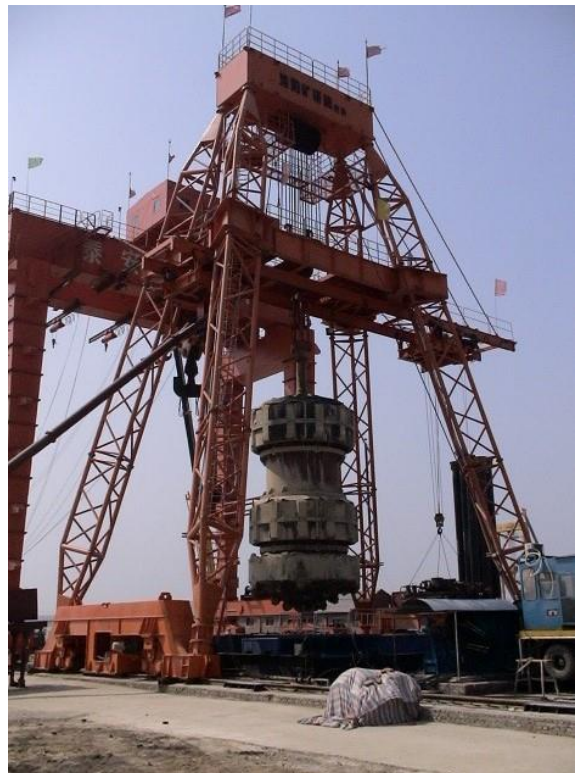
Рис. 24. Бурова установка AS 12/800 на рейковому ході
