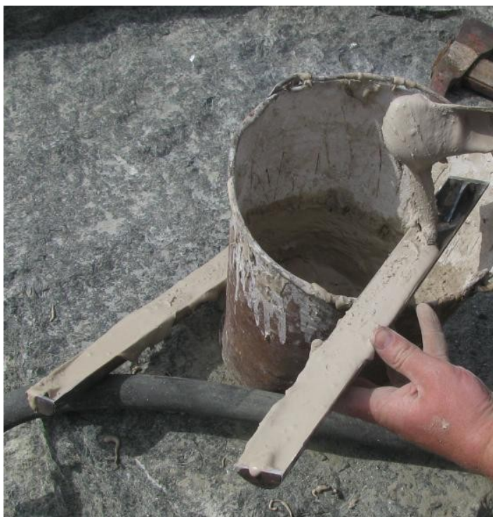
Рисунок 7.5 – Заливка НРС в патрони
