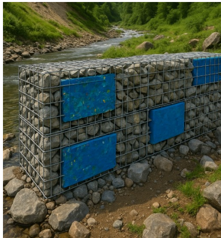
Рисунок 1 – Гібридна конструкція габіонів проти селевих чи зсувних процесів
