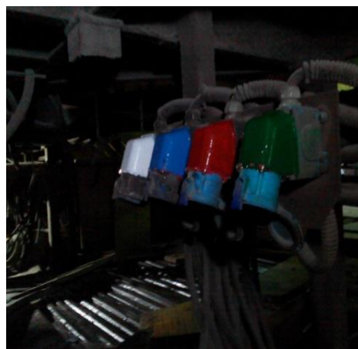
Рисунок 8.10 – Кольорове маркування роз'ємів центрифуги
