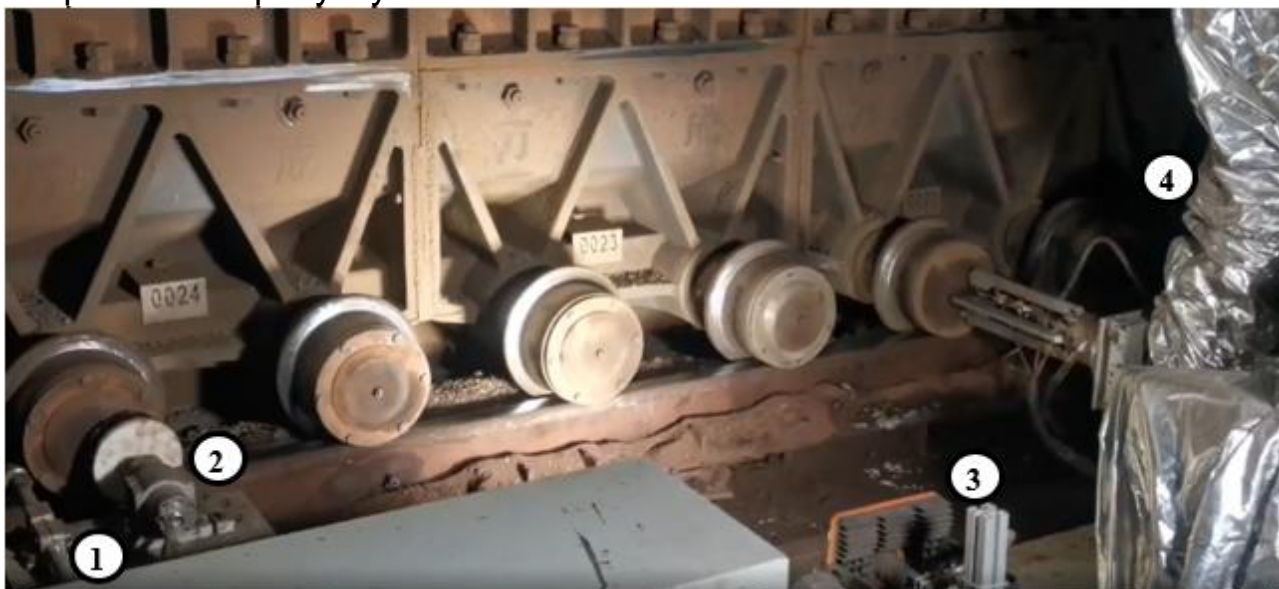
Рис. 14. Фото оснащення робочого місця системи очищення и змащування коліс візків. Система точного вимірювання швидкості та положення – 1, система очищення – 2, система діагностування, контролю положення та зчитування облікового номеру – 3, система змащування коліс – 4
