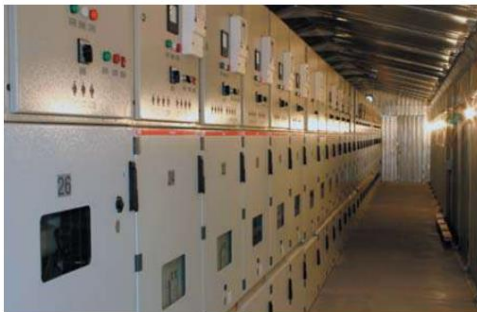
Рисунок 6.4 - Комплектна розподільна установка серії КУ-10С
