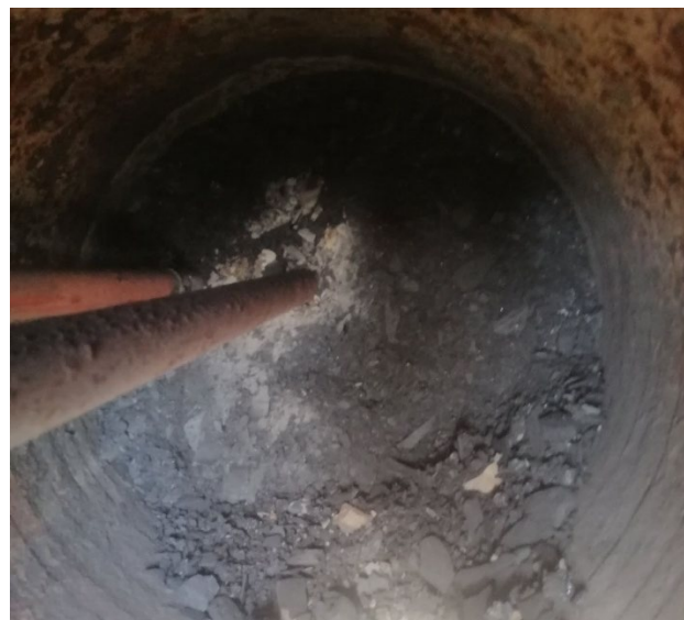
Рис. 4. Загальний вигляд зольного залишку у реторті комплексу з переробки відходів
