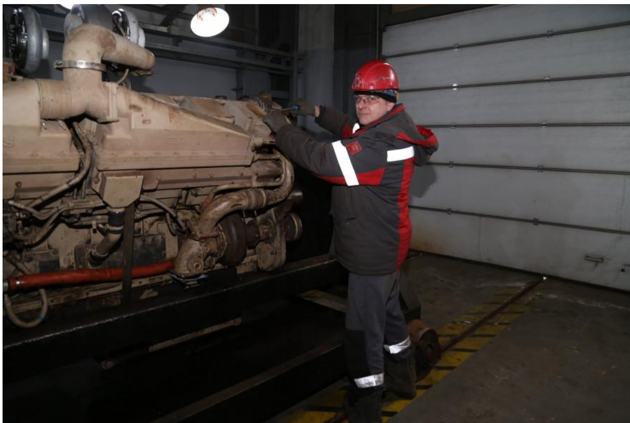
Рисунок 3.6. Слюсарні роботи під час ремонту обладнання
