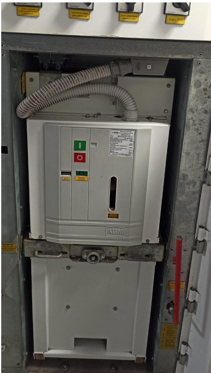
Рисунок 2.9 – Вимикач ВБ-4-П на візку комірки ВМ-1
