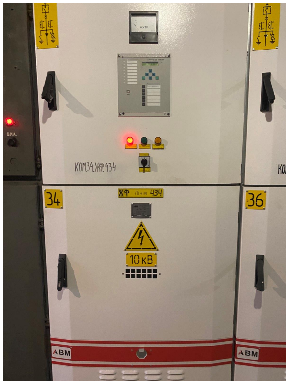
Рисунок 2.13 – Змонтований термінал МРЗС на комірку
