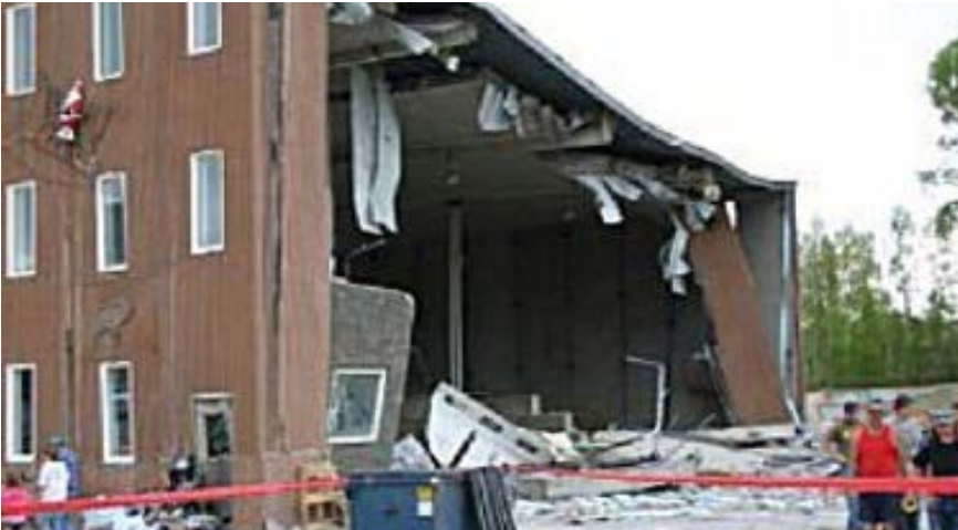
Зруйнована будівля заводу
