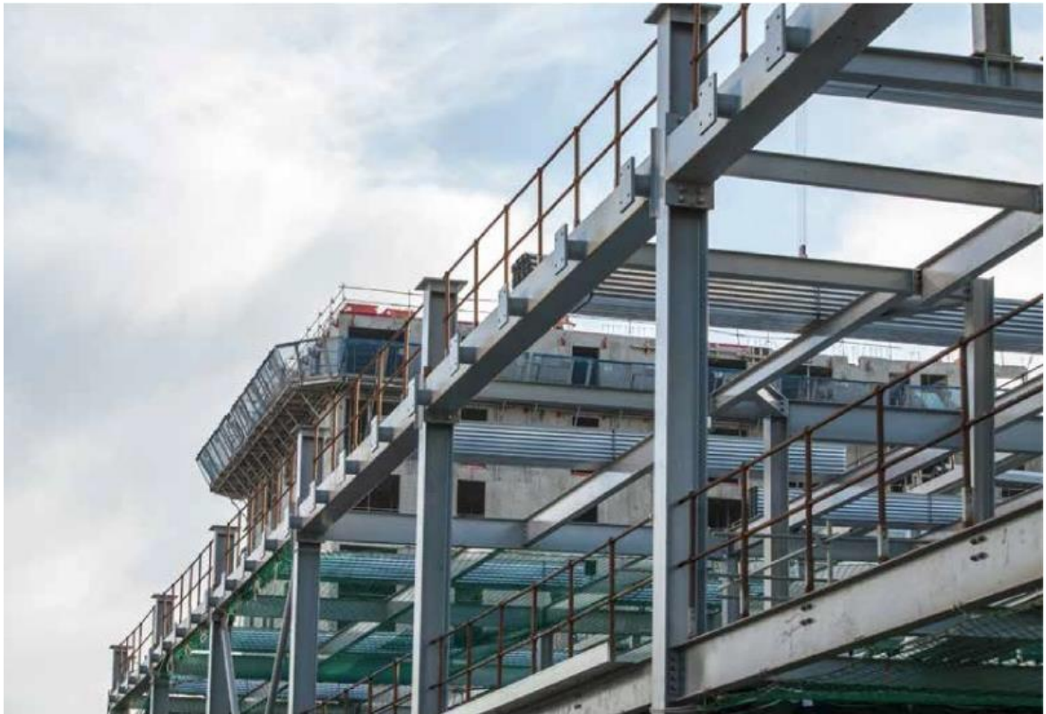
Рисунок 1.8 Металеві конструкції на етапі будівництва кварталу Джерело: [11]
