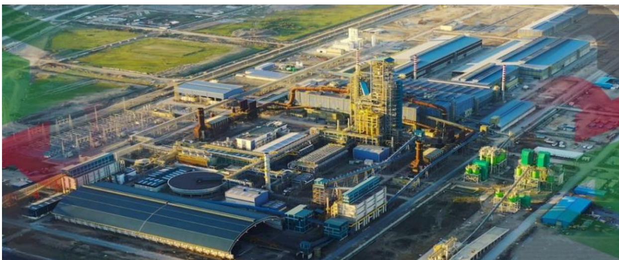
Рисунок 1.2 - AQS Bellara, Алжир — модуль Midrex потужністю 2,5 млн т/рік.
