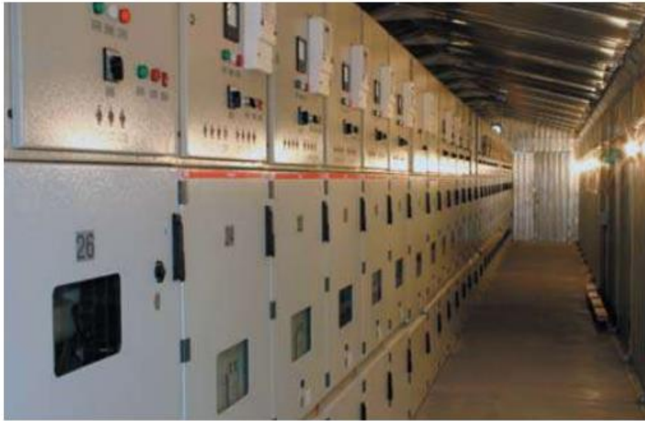
Рисунок 7.4. Комплектна розподільна установка серії КУ-10С
