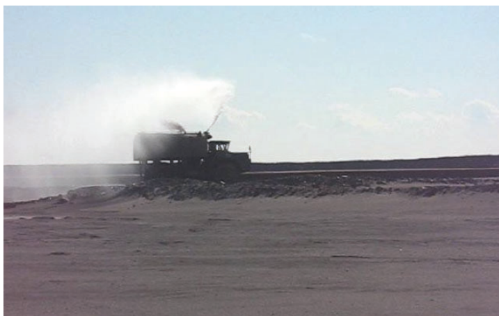
Рисунок 2.15 – Нанесення розчину на поверхню хвостосховища [31-34]
