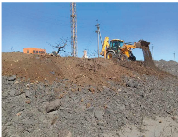
Рисунок 1.4 – Нанесення мулових осадків [7, 17]
