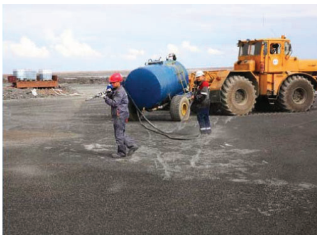
Рисунок 2.9 – Закріплення поверхні екофіксатором PG-100 [29]
