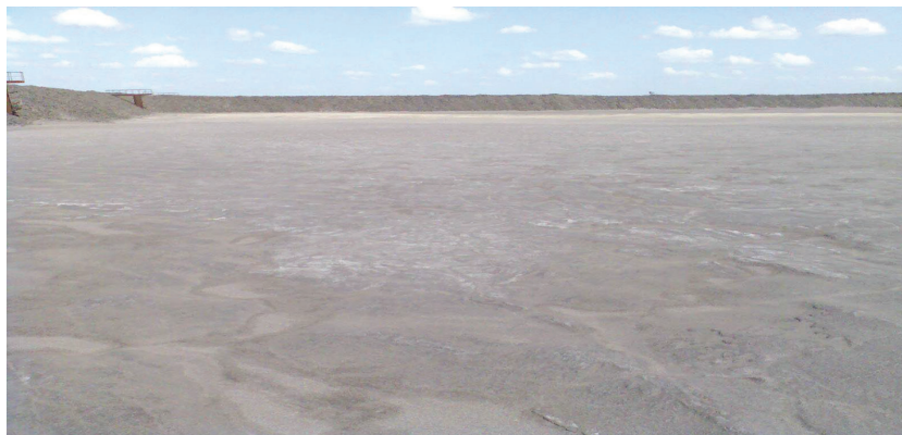
Рисунок 2.10 – Загальний вигляд хвостосховища, закріпленого бішофітом [32]
