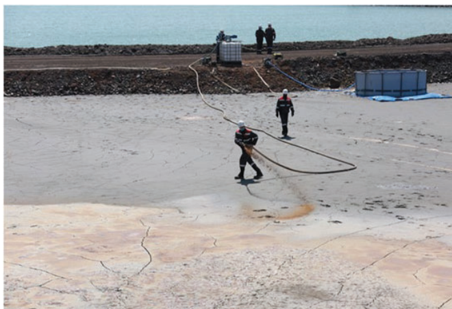
Рисунок 2.7 – Нанесення реагенту «VTA 50»
