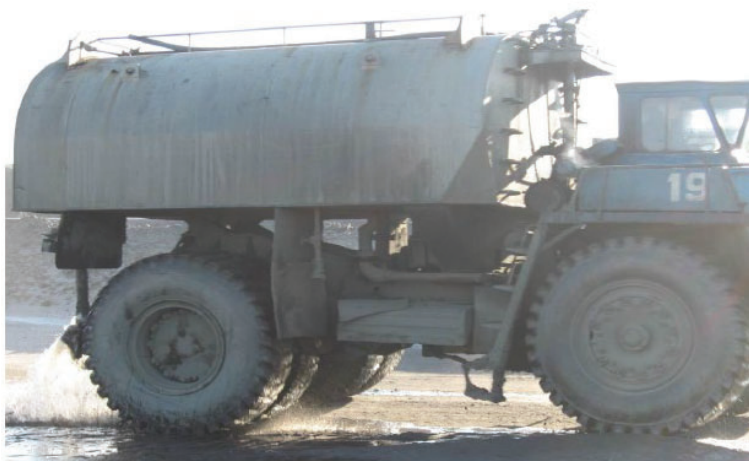
Рисунок 2.14 – Нанесення бішофіту на поверхню автодороги [31-34]
