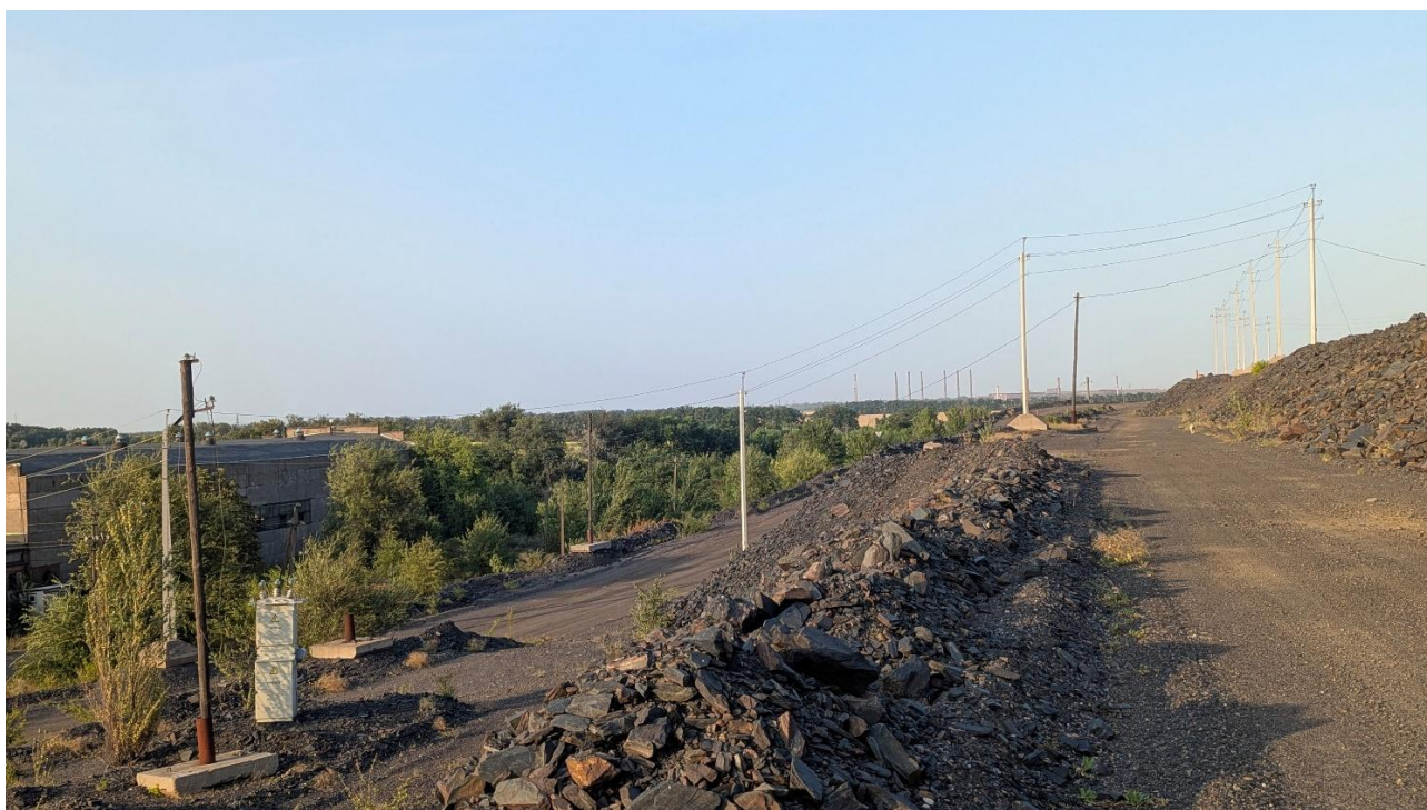
Рисунок 1.1 – Насосна станція зворотного водопостачання ЦГЗК
