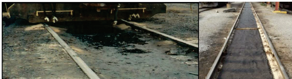
Рисунок 3.17 – Стан колій «до» та «після» використання сорбентів [15]
