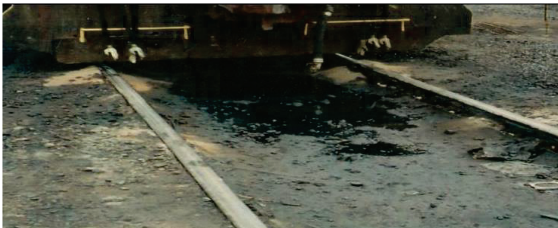
Рисунок 1.6 – Розлив нафтопродуктів на залізничних коліях до встановлення системи збору нафтопродуктів [19]
