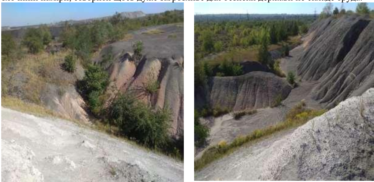
Рис 2. Лінійна ерозія захисних дамб хвостосховища
