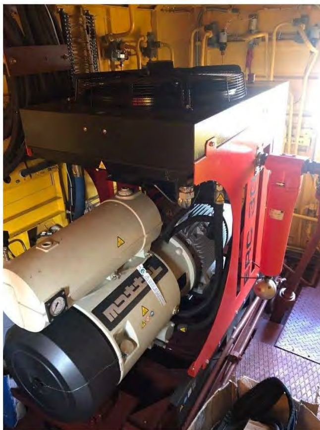
Рисунок 1.6 – Компресорна установка роторно пластинчатого типу Mattei ERC 30 з мікропроцесорним керуванням
