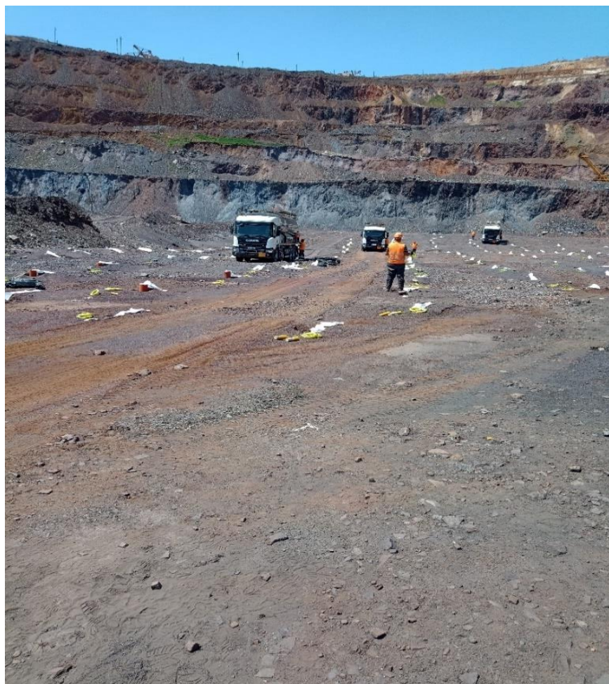
Рисунок 2.2. – Процес заряджання бурового блоку в кар'єрі
