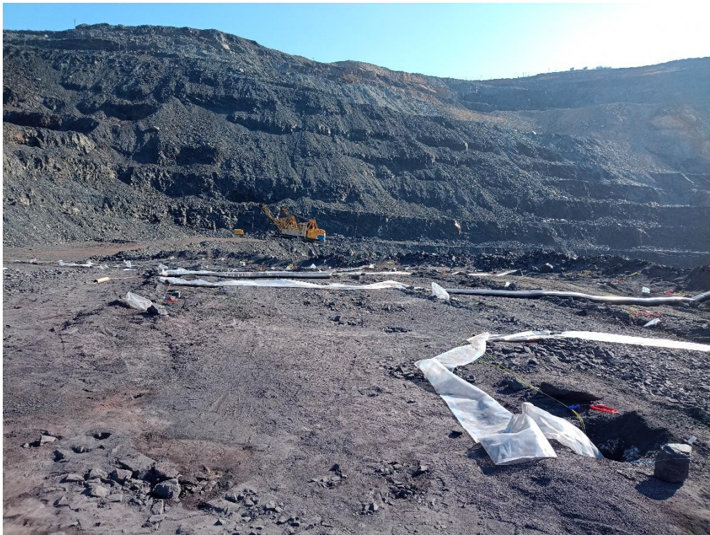
Рисунок 2.3. – Виконання заходів з екології на блоці (зовнішня гідрозабійка з реагентом)
