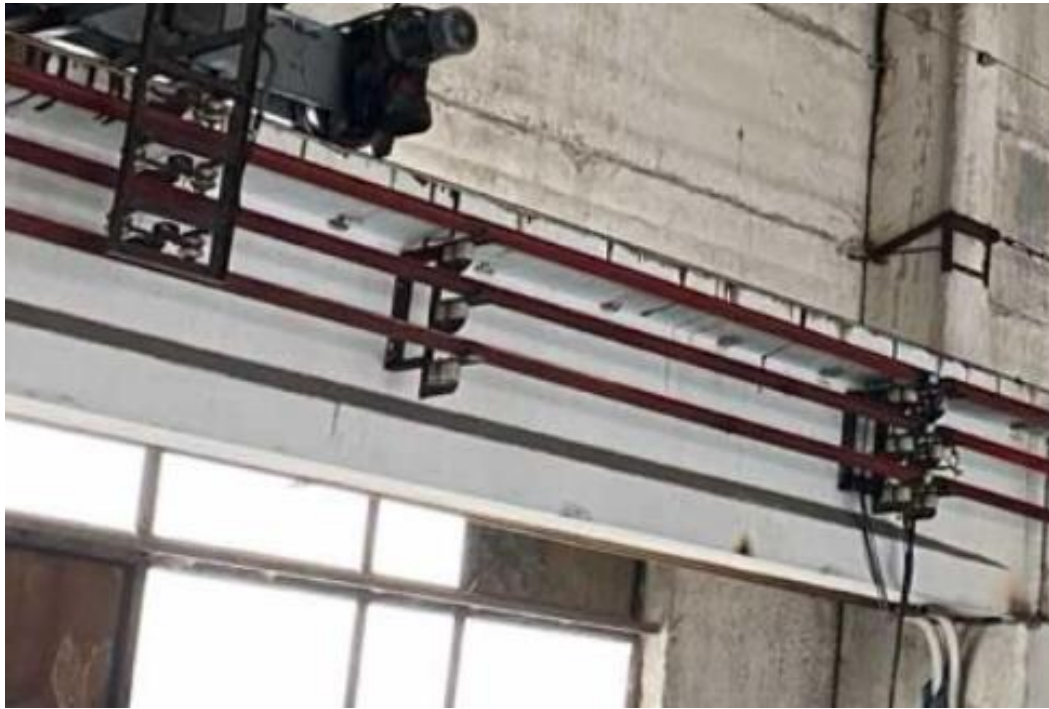
Рисунок 1.3 – Системи тролейного живлення
