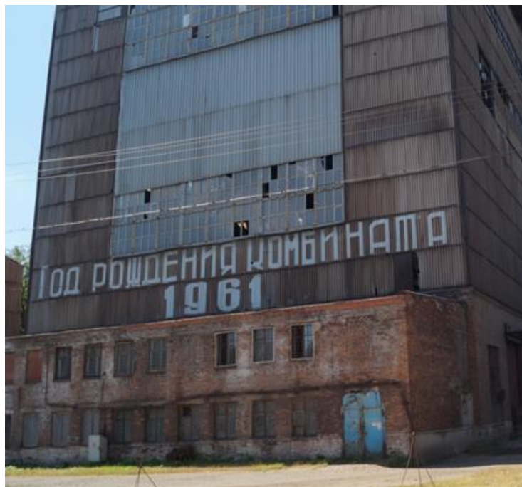
Рис. 1.1 – дробильна фабрика ГЗК
