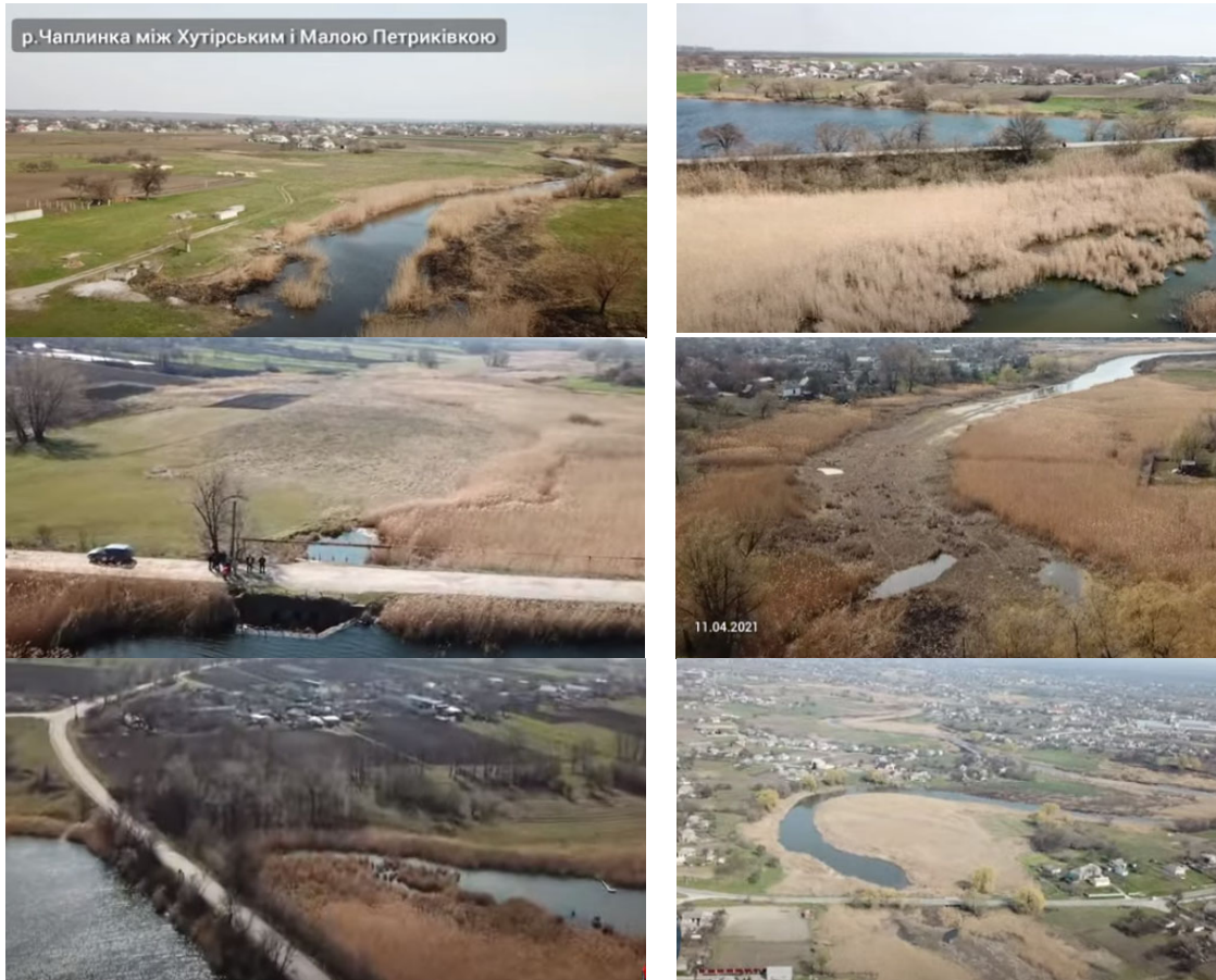
Рис. 5. Стан р. Чаплинка після розчищення русла на ділянці від с. Хуторське, с. Мала Петриківка, за даними на 11.04. 2021 р. [12]
