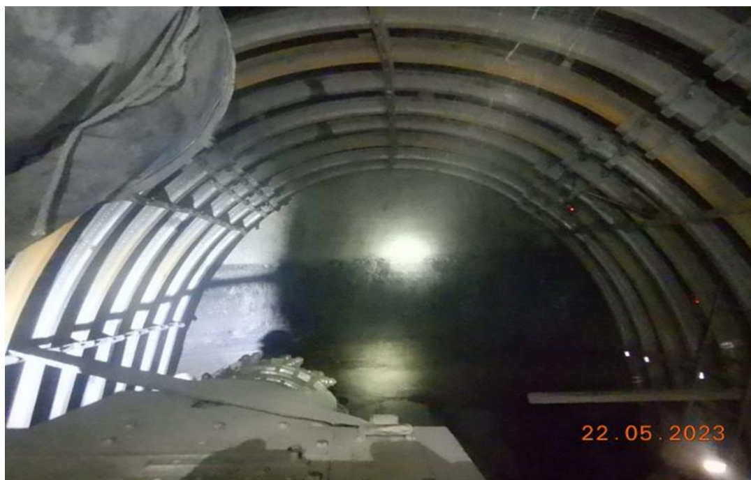
Рисунок 2.5 Щойно встановлені рами кріплення у вибої
