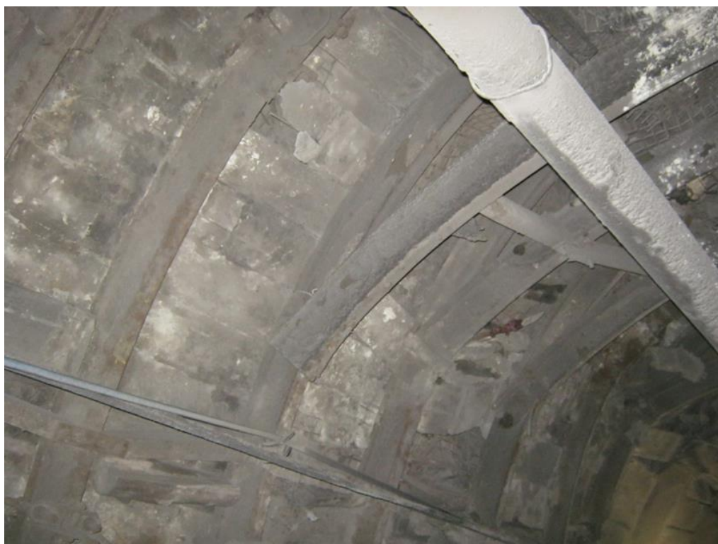
Рисунок 2.3. Руйнація замків піддатливості з розривом хомутів
