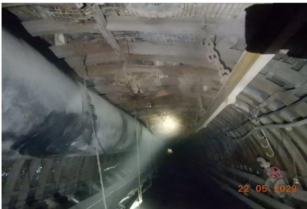
Рисунок 2.6. Деформовані верхняки рамного кріплення поблизу привибійної зони
