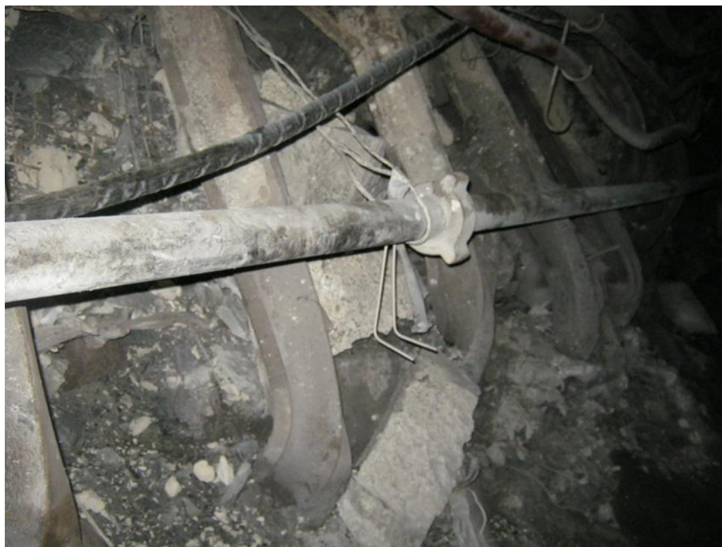
Рисунок 2.4 Скручування та вигин стояків з витисканням породних стінок
