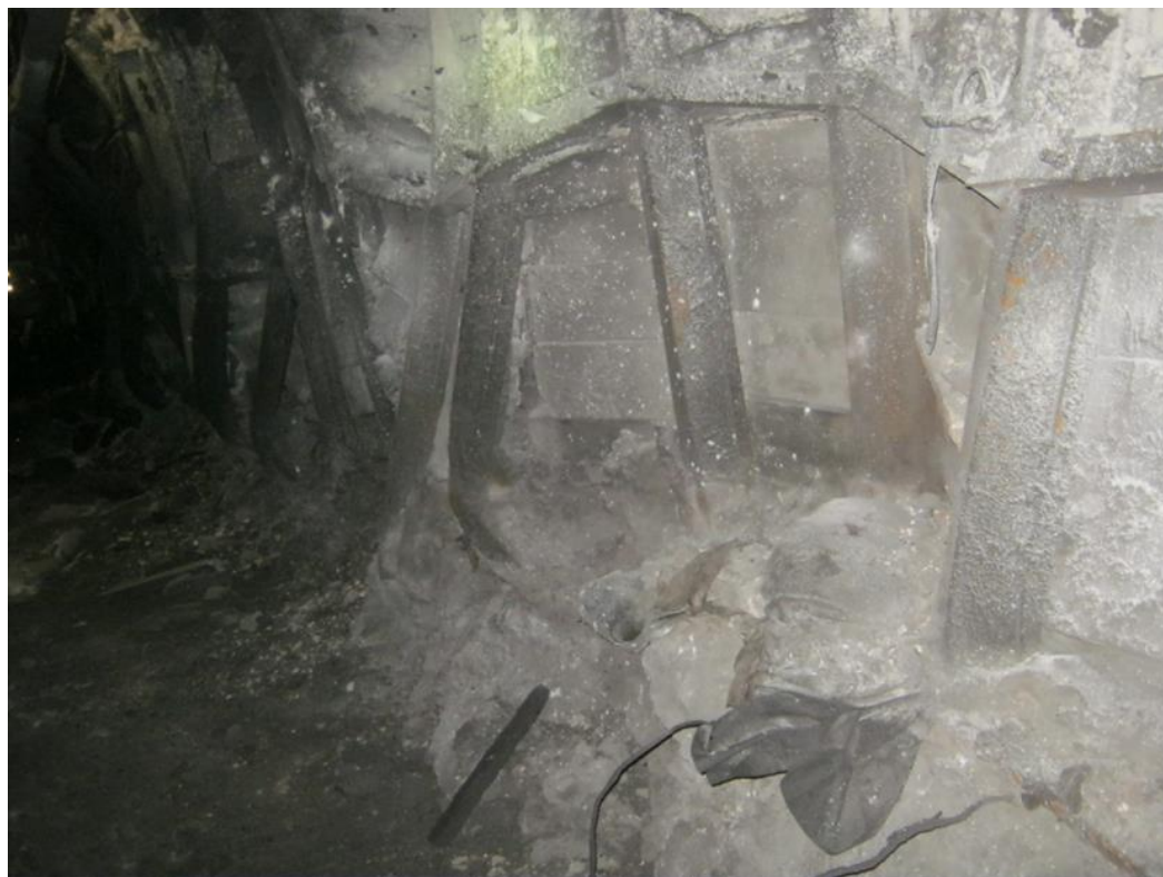
Рисунок 2.2. Скручування СВП стояків та руйнація міжрамних стяжок
