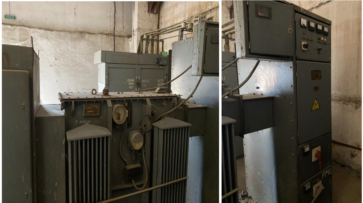
Рисунок 2.4 - Високовольтні комірки, релейні та захисні (комутаційні) апарати
