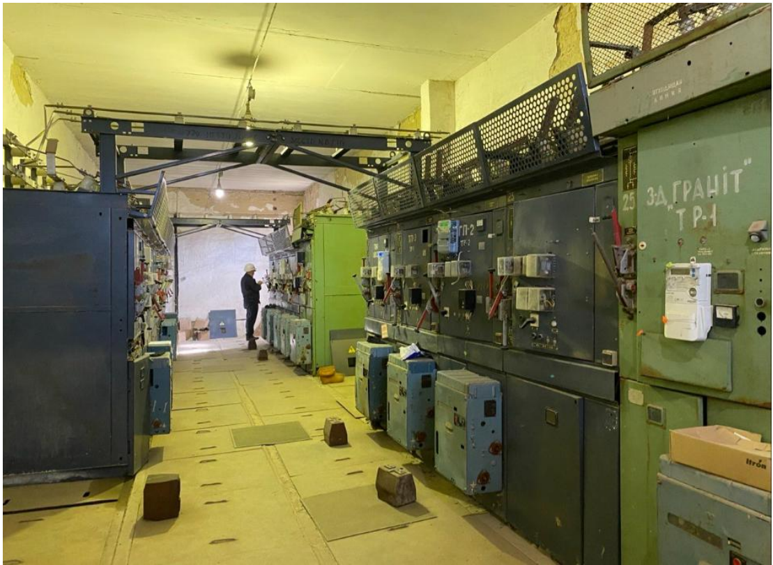
Рисунок 2.3 – Існуючий розподільний пункт РУ-10 кВ підприємства
