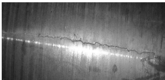
Рис. 4.4. Наскрізна гартівна тріщина в наплавленому металі
