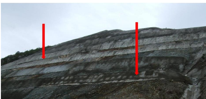
Рисунок 7.27 – Зацементований схил дамби хвостосховища
