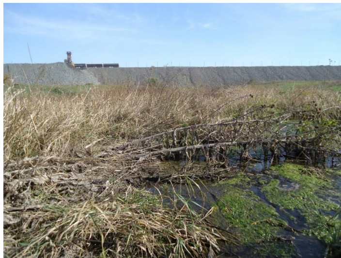
Рисунок 4.6 – Витік джерела у підніжжя нового уступу на півдні відвалу
