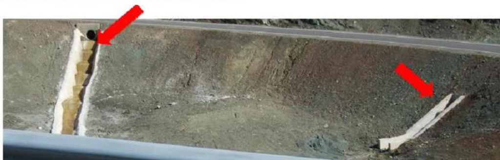
Рисунок 7.31 – Дренажні водоскиди каскадного типу
