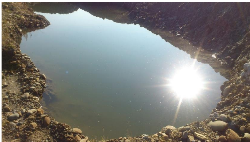
Рисунок 7.10 – Гребінь дамби хвостосховища. Скупчення солоної води, що призводить до суффізії матеріалу дамби
