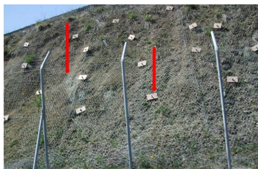
Рисунок 7.30 – Фіксація схилу дамби хвостосховища анкерним і сітчастим кріпленням
