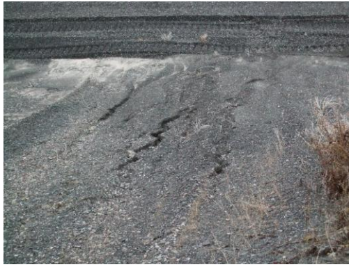
Рисунок 7.1 – Зовнішній укіс дамби хвостосховища: дрібні вимоїни можуть призвести до утворення ярів
