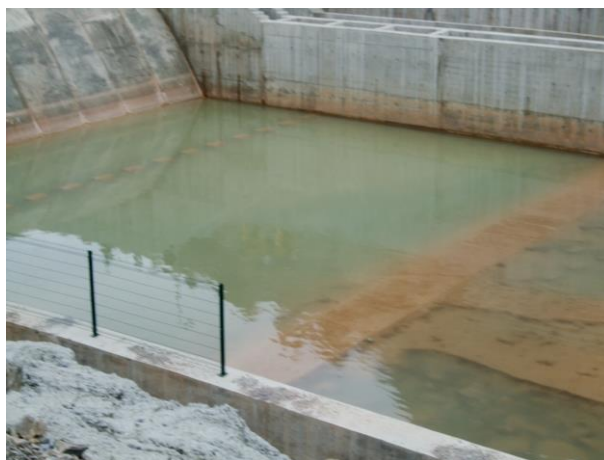
Рисунок 7.32 – Приклад розширеного дренажного бетонного водоскиду
