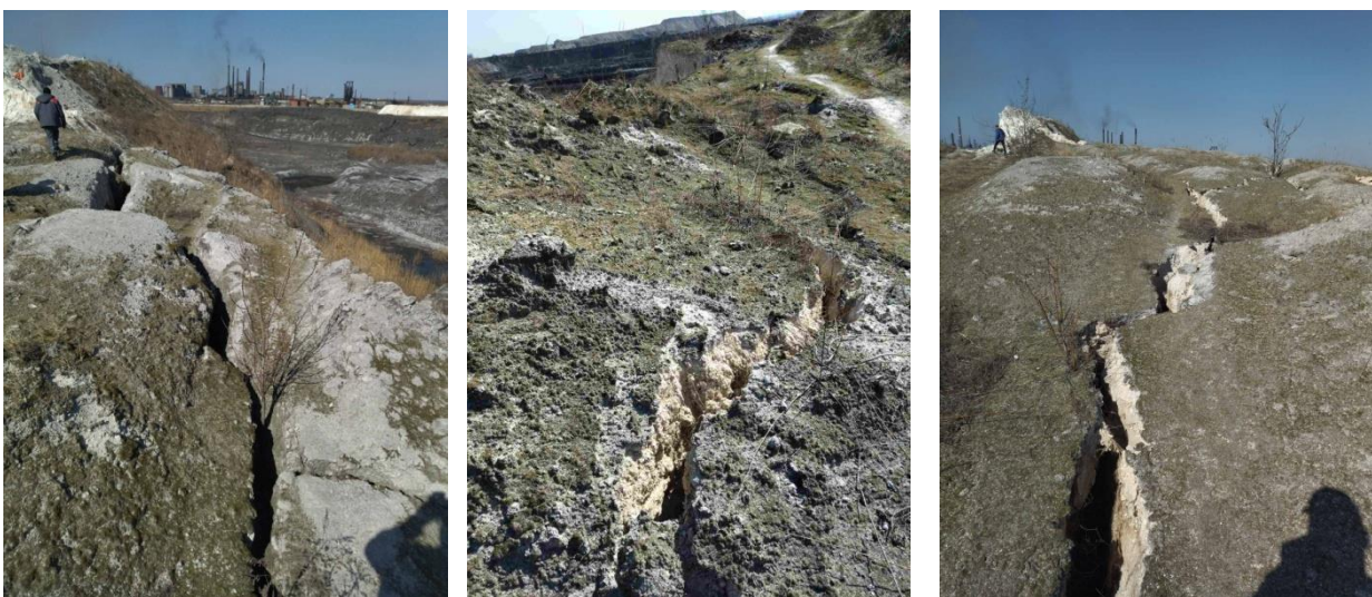
Рисунок 7.23 – Прояви небезпечних інженерно-геологічних явищ – обвали, зсуви та розтріскування потужного шару фосфогіпсу на північній дамбі
