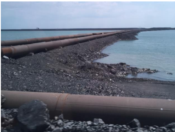
Рисунок 7.34 – Насипна гребля підтримує трубопровід для подачі хвостових матеріалів (шламів)
