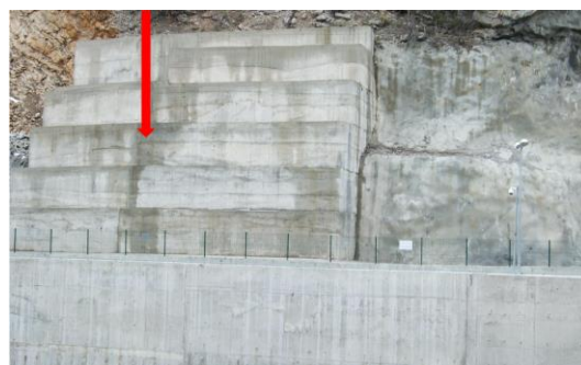
Рисунок 7.28 – Бетонна підпінна стінка, що запобігає сповзанню ділянки дамби
