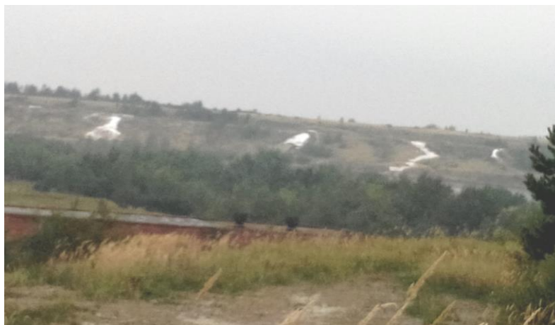
Рисунок 7.14 – Зовнішні схили дамби хвостосховища. Відкладення солей унаслідок фільтрації розчинів через тіло дамби
