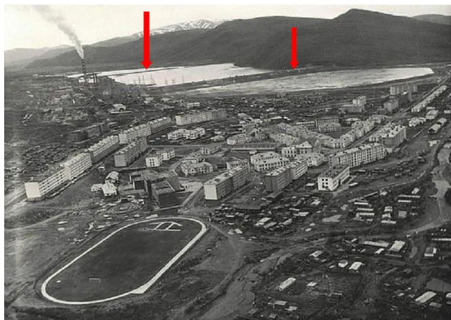
Рисунок 7.26 – Роздільні дамби, що відокремлюють частини (секції) золовідвалу теплової електростанції
