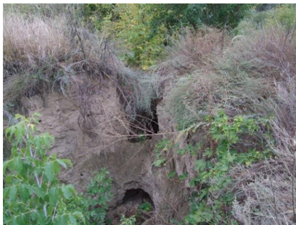
Рисунок 7.11 – Гребінь і схил дамби, складеної пухкими матеріалами. Отвори великого розміру в тілі греблі дамби свідчать про інтенсивну суффізію. Це вкрай неприпустиме явище
