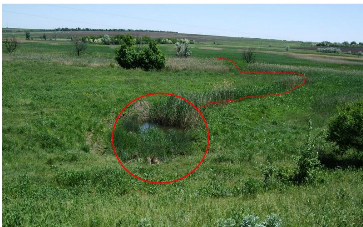
Рисунок 7.12 – Зовнішнє підніжжя дамби хвостосховища. Фільтрація води через дамбу і вихід у вигляді джерела (Вид із дамби)
