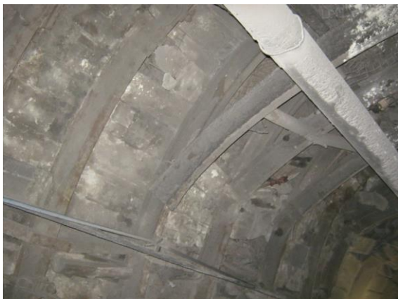
Рис. 3. Руйнація замків піддатливості з розривом хомутів
