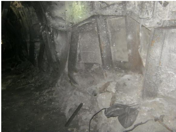
Рис. 2. Скручування СВП стояків та руйнація міжрамних стяжок
