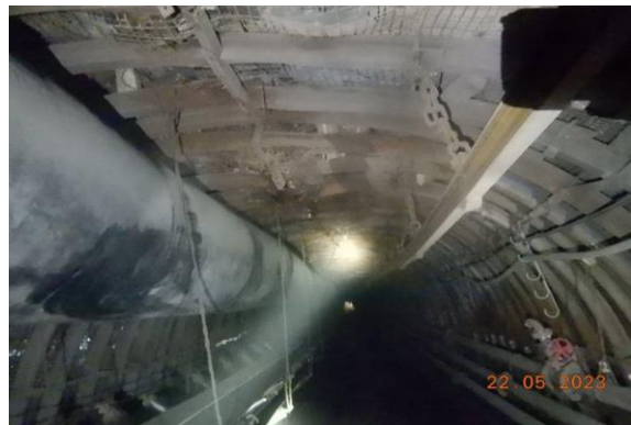
Рис. 6. Деформовані верхняки рамного кріплення поблизу привибійної зони
