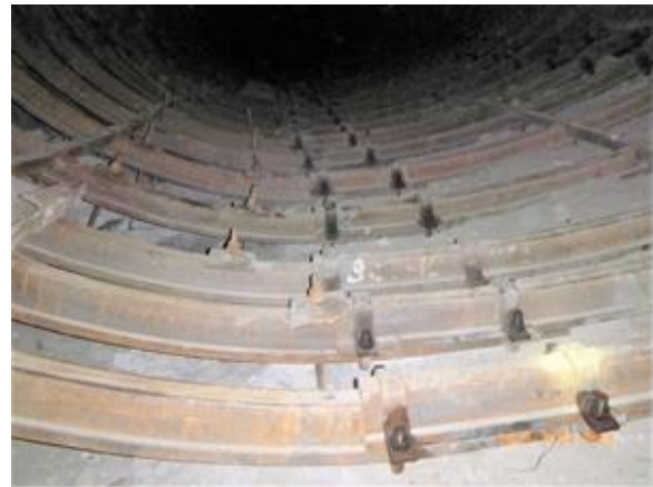
Рис. 19. Елементи рам та анкери зворотного склепіння перед бетонуванням
