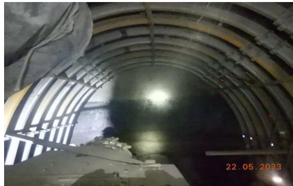
Рис. 5. Щойно встановлені рами кріплення у вибої
