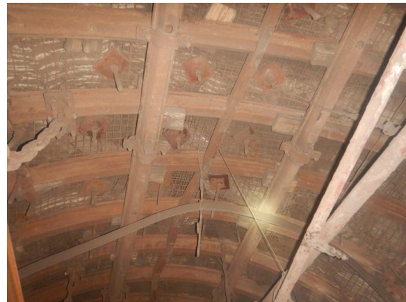
Рис. 23. Анкерування покрівлі та поздовжні балки на експериментальній ділянці
