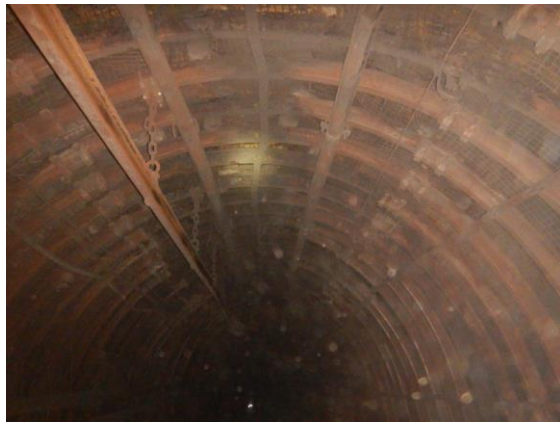
Рис. 21. Подвійне поздовжньо-балкове підсилювальне кріплення з СВП27
